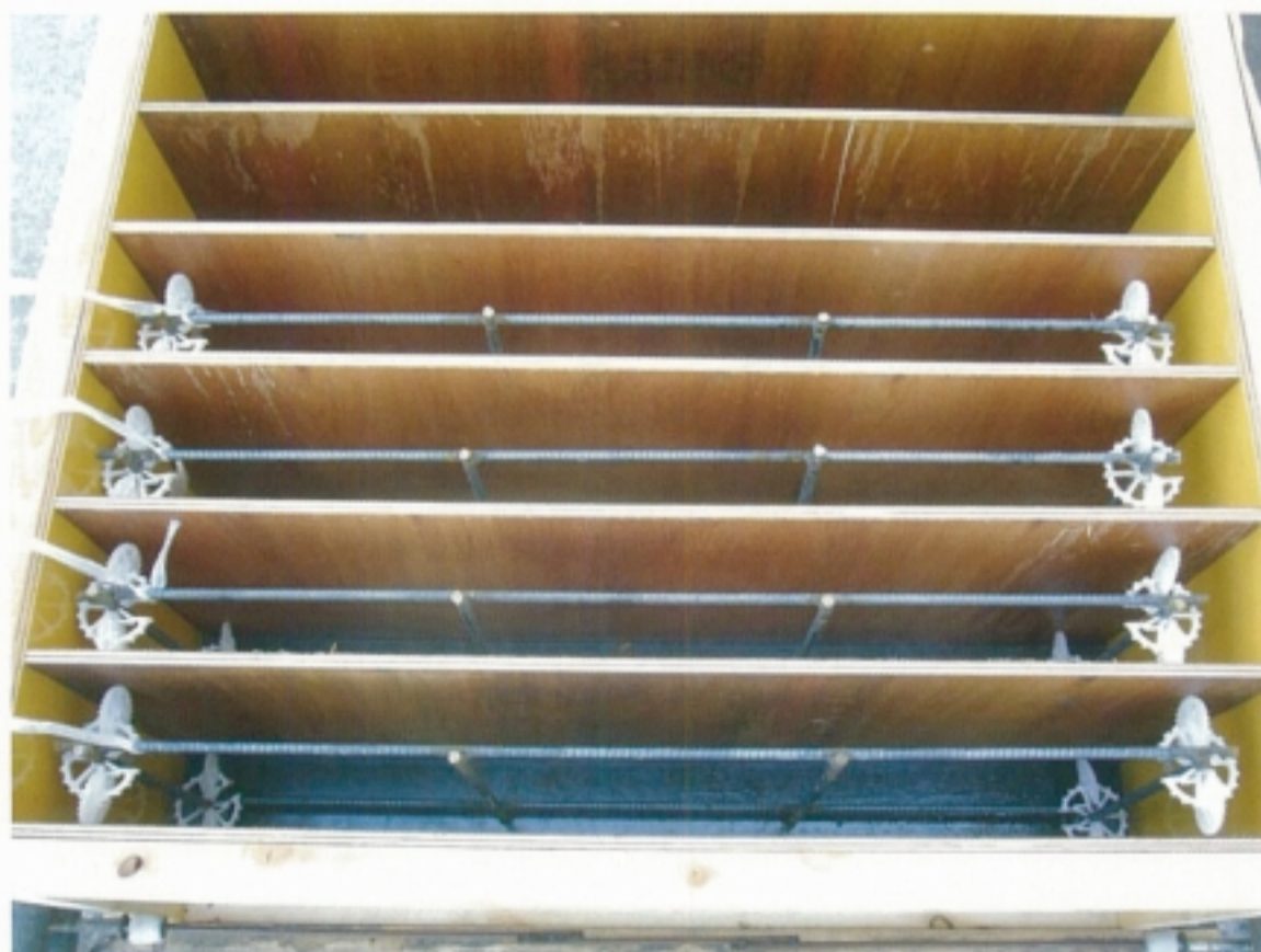
写真-2. 鉄筋配置状態
