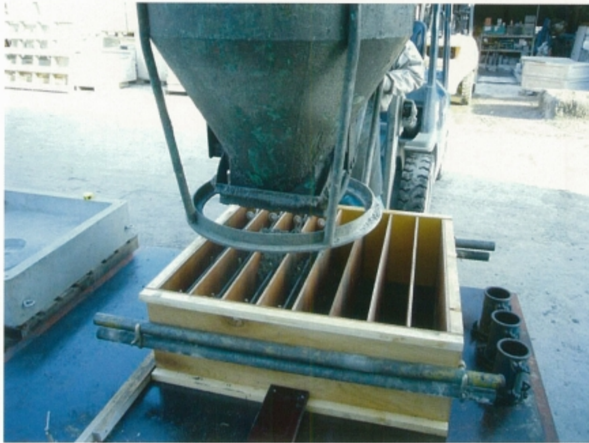
写真-3. コンクリート打設
