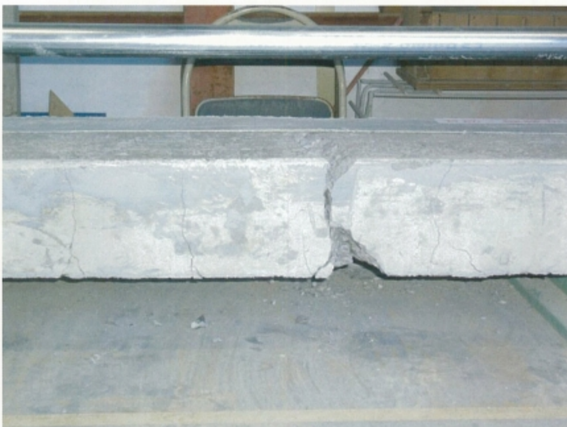
写真-16. 供試体底面の破壊ひび割れ [d-1：有筋・繊維布貼付]
