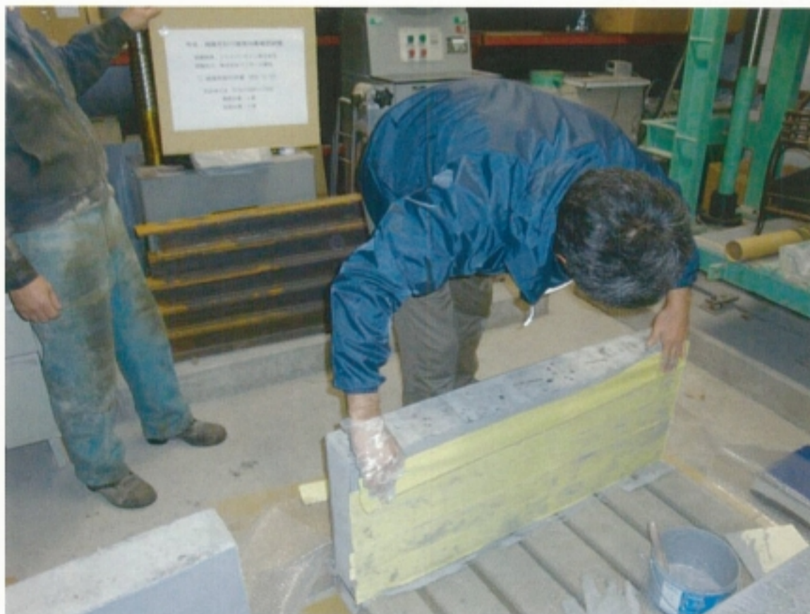
写真-6. 繊維布貼付作業中
